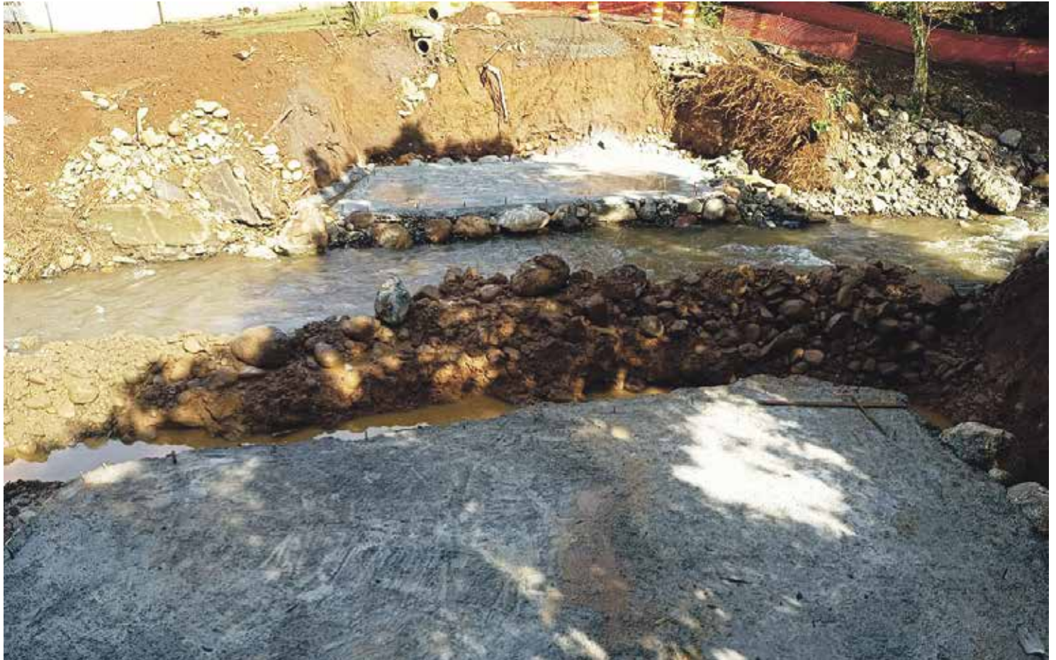
Construcción de puente La Cedeña.
