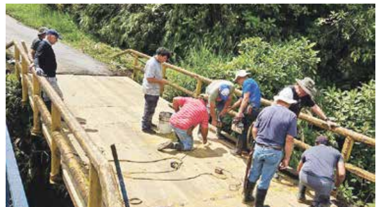
Colocación de nuevos tablonces en los puentes de Toro Amarillo.
